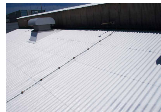
スレート屋根施工状況
