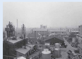
本山工場(神戸工場、旧・油脂工場)
